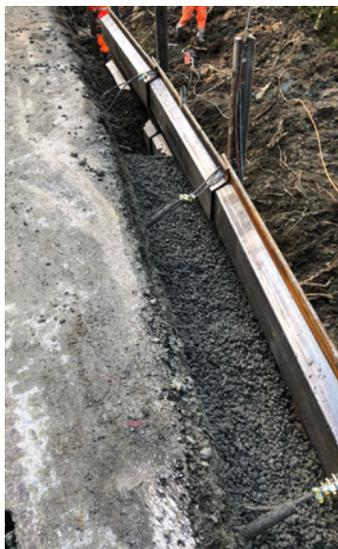
Sickerbeton als erste Zwischenschicht
