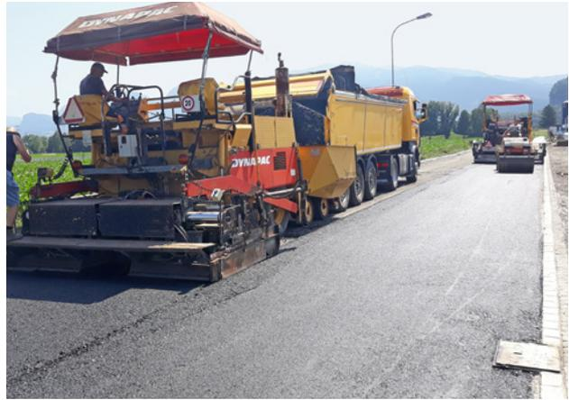
Einbau des Deckbelags mit zwei versetzten Fertiggern
