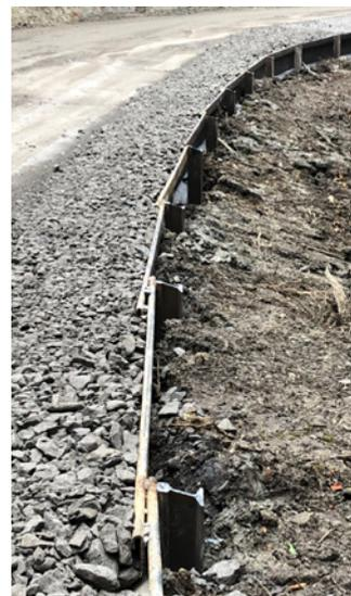
fertige Böschungssicherung im System «Ribbert»
