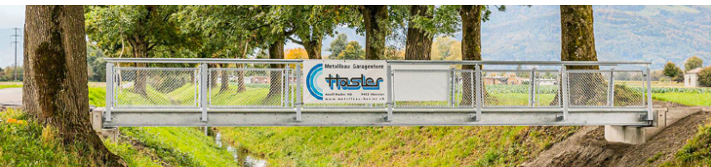
Die neu erstellte Fussgänger-Stahlbrücke
