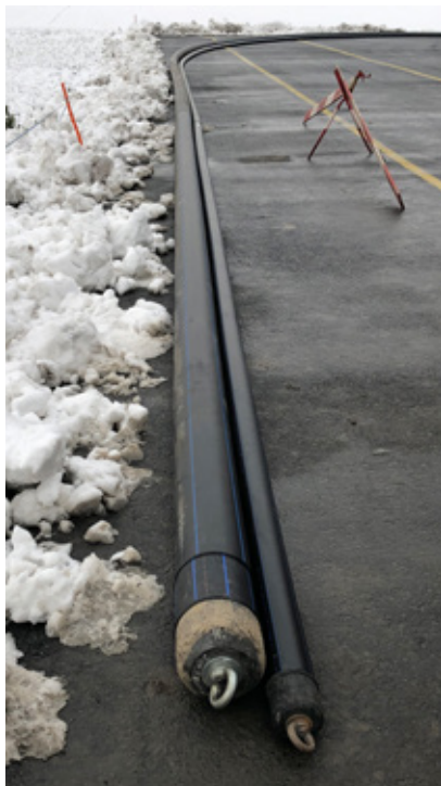
Bereitgestellte Rohrmaterialien: Schutzrohr PE DN 200 mm / Druckleitung PE DN 110 mm
