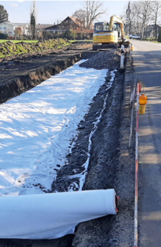
Geotextilie als Trennschicht zwischen Planie und Schüttung
