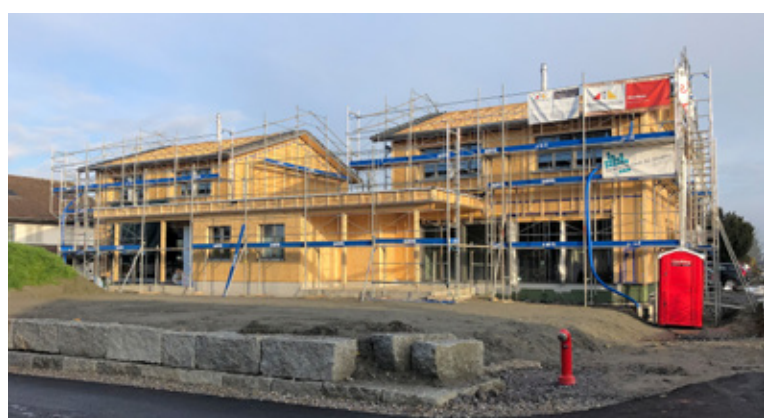
Doppeleinfamilienhaus im Bau, Kriessern
