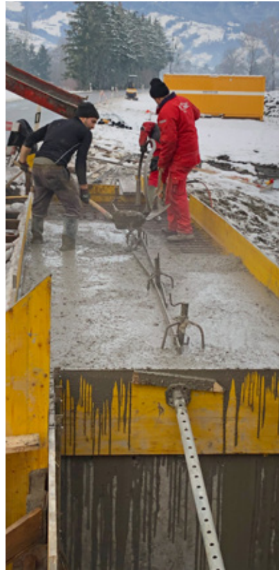
Betonieren der Fussgänger-Brückenplatte über den Mädlibach
