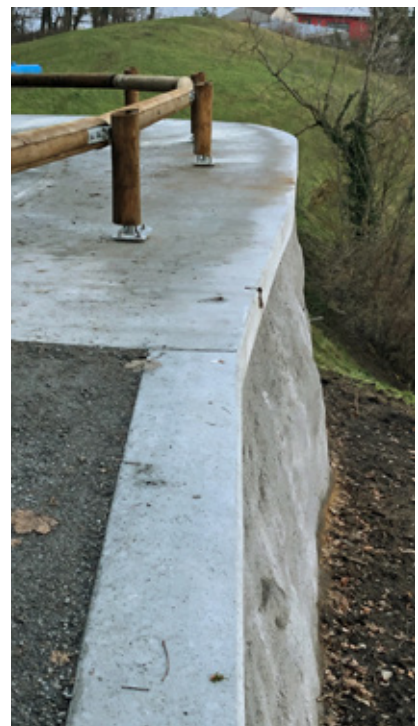
Fertig sanierte Stützmauer mit neuem Abirrschutz
