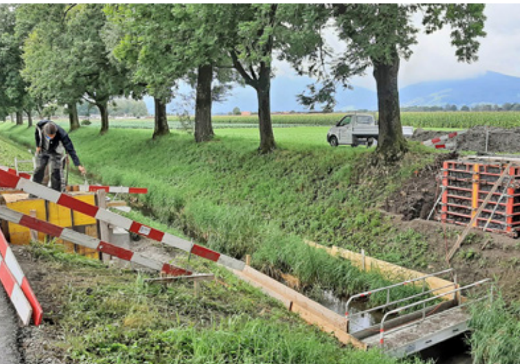
Erstellung der beiden Brückenfundamente
