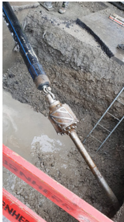
Pilotbohrung in der Zielgrube: Bereit für Rückzug in die Startgrube (unter dem RBK) mit Aufweitkopf und angehängtem Schutzrohr PE DN 200 mm
