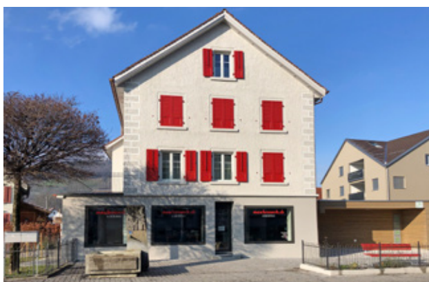
Sanierung/Anbau Wohn- und Geschäftshaus, Oberriet
