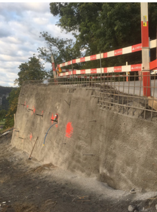
Spritzbetonschicht mit Bewehrung und «Vernagelung» mit permanenten Anker
