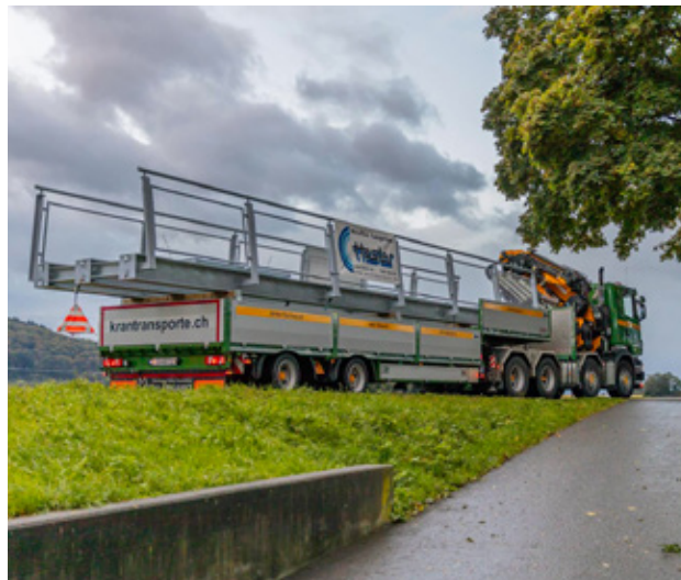
Antransport der fertigen Stahlbrückenkonstruktion
