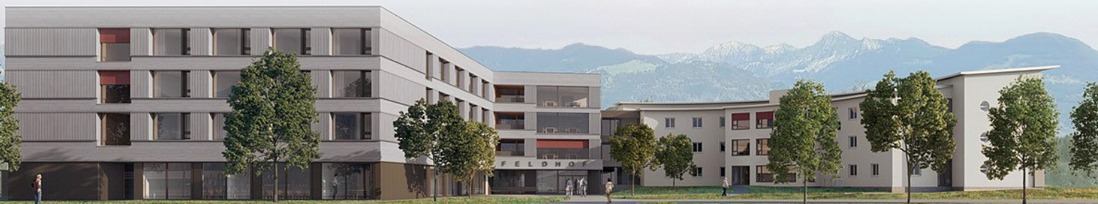
Gesamtansicht Neubau und Rundbau
