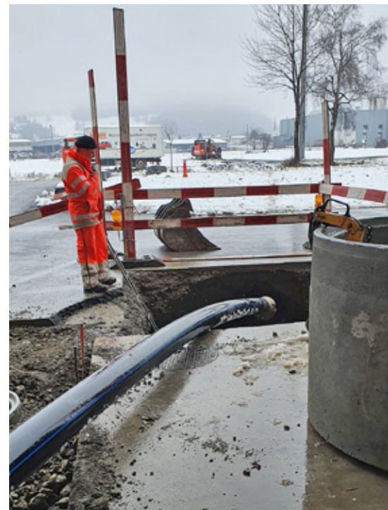
Der Rückzug des Schutzrohres PE DN 200 mm mittels «Bohr- und Zugmaschine» (im Hintergrund) ist gestartet
