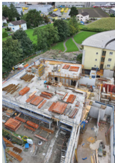
1. Etappe: Erstellung EG
