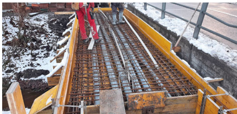
Brücke vor Einbringung des Betons, mit eingelegten Schutzrohren für Werkleitungen
