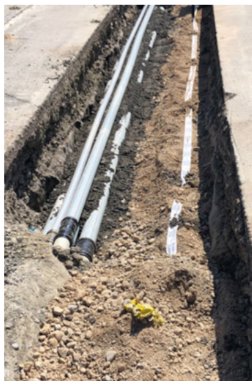
Gemeinsamer Werkleitungsgraben von diversen Werken
