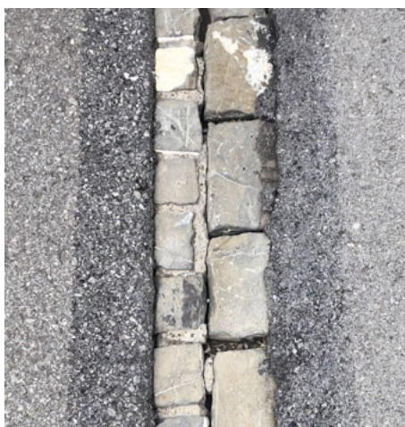
Mit Hochdruck gereinigter Randabschluss
