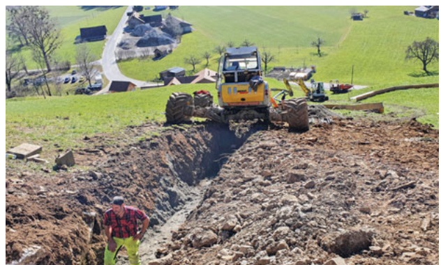
Einbau Transportleitung Semelenberg
