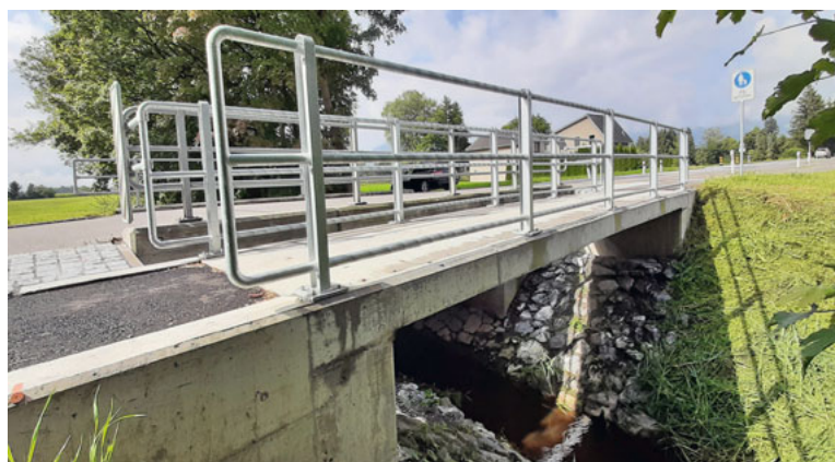
Brücke nach Fertigstellung
