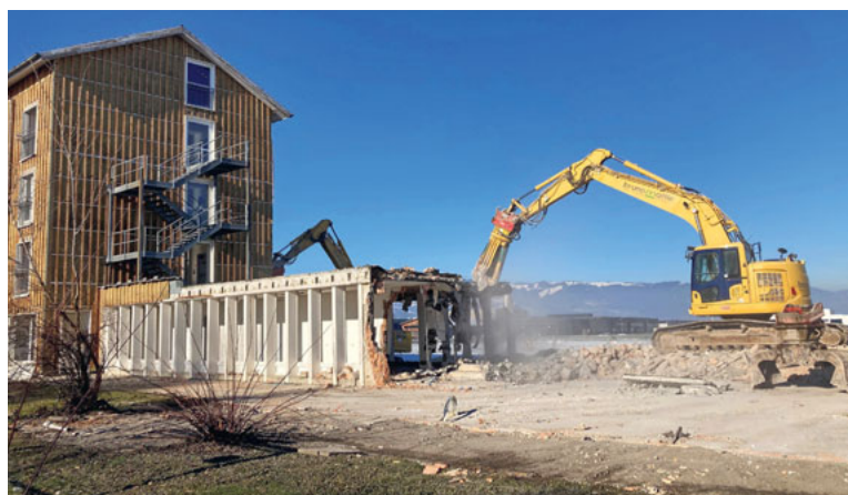
Abbrucharbeiten Haus Ost sind bereits im Gang
