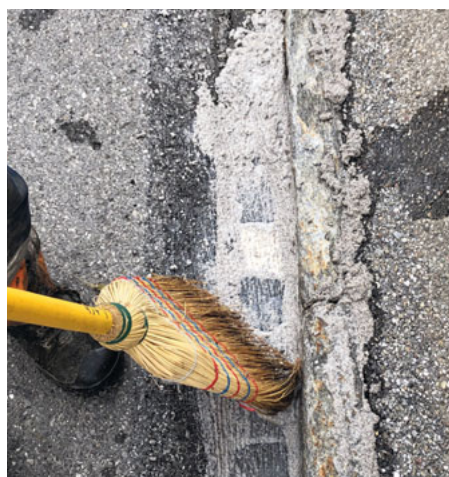
Einbringen des neuen Fugenmörtels
