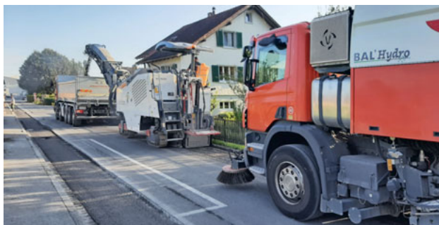
Sanierung von Randabschlüssen
