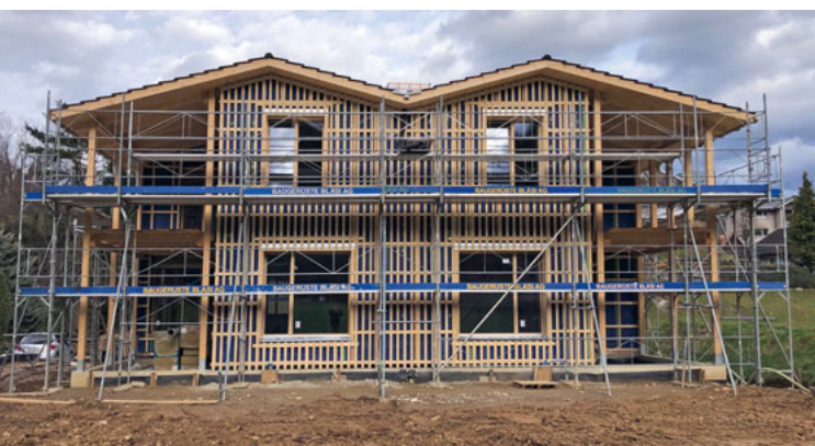
Doppeleinfamilienhaus im Bau, Kobelwald
