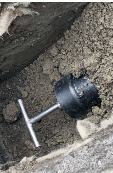
Hygienetechnisches Abdichten der Trinkwasserleitung bei Etappierungen.
