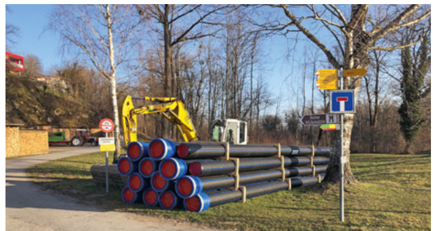
Rohrmaterial Transportleitung Semelenberg
