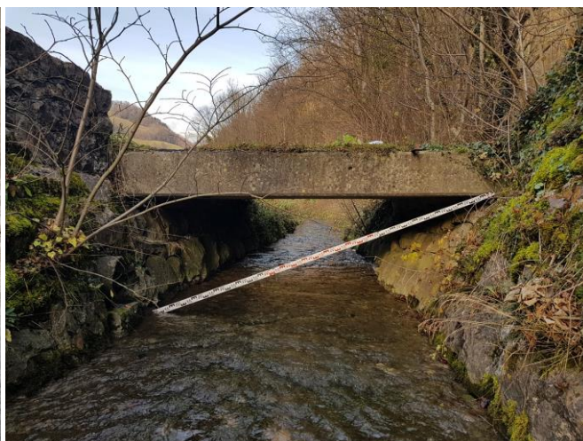
Abb. 21: Brücke Strasse im Rehag
