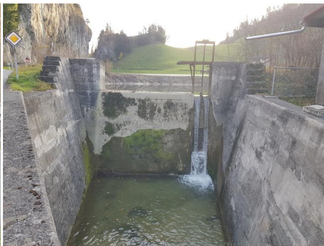
Abb. 19: Staumauer und Tosbecken
