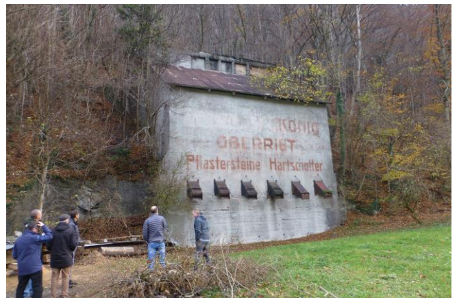
Abb. 17: ehemalige Abfüllanlage Parz. 631 (29.11.2018)
